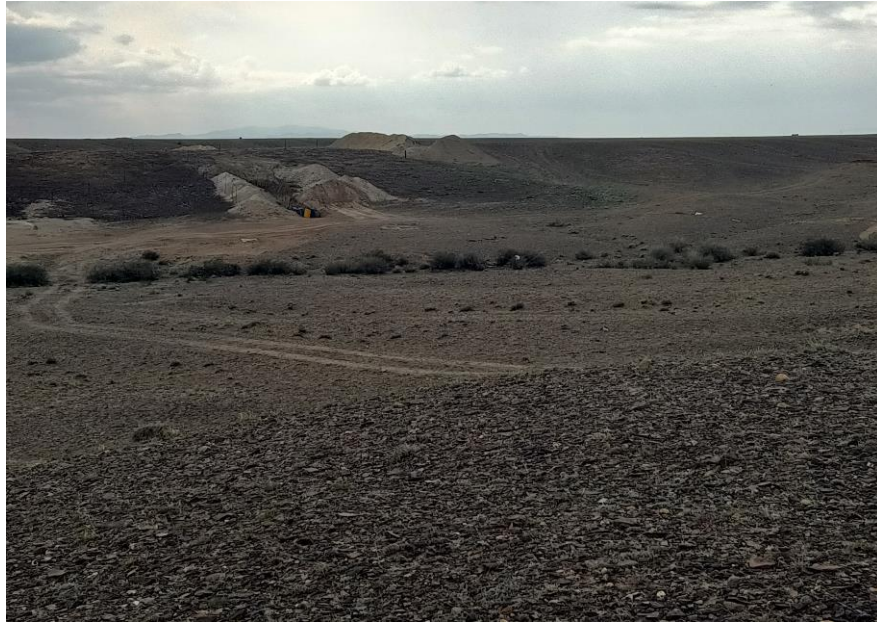
图 1-3-11 已建矿山道路局部
